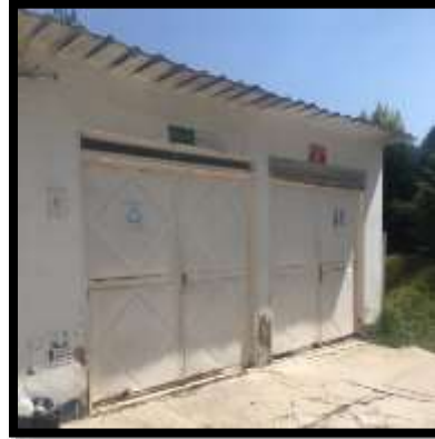
Fotografía 9. Almacenamiento central de residuos
