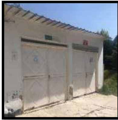
Fotografía 9. Almacenamiento central de residuos
